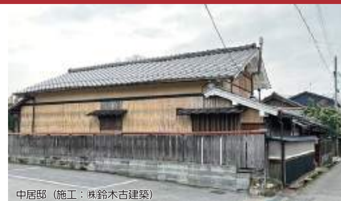
中居邸 (施工: 株鈴木古建築)
